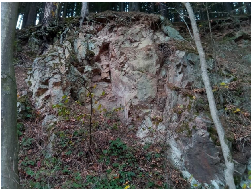
Obr. č. 9: Km 0,750 – 0,850; rozvětralý a tektonicky porušený skalní masiv
